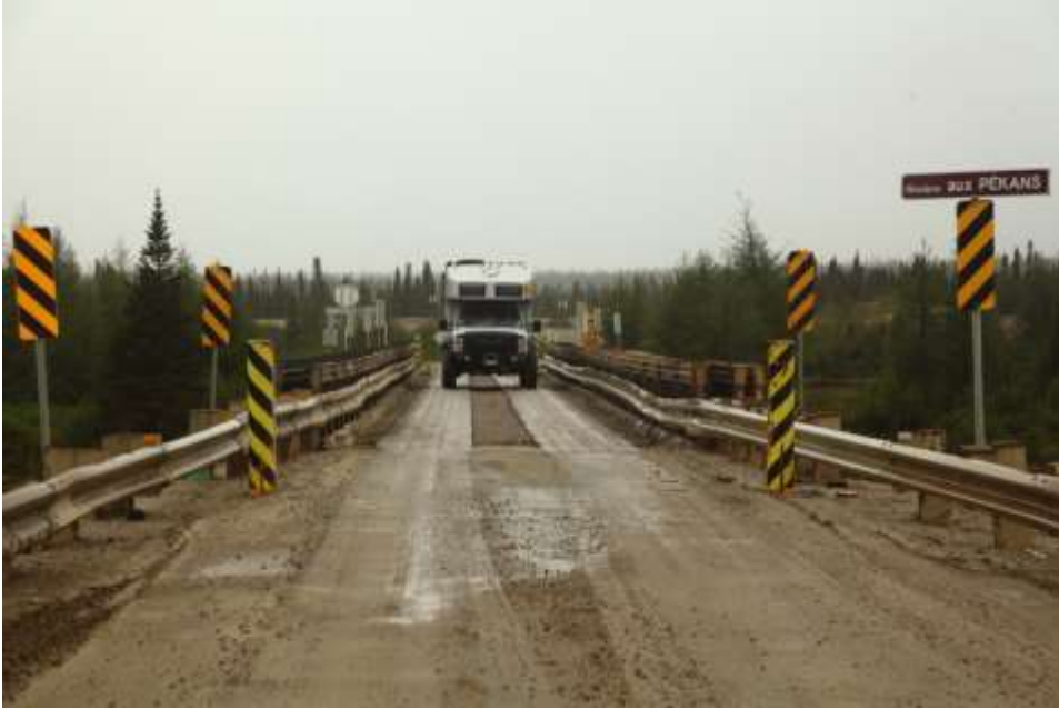
One lane bridge over Rivière aux Pékans
